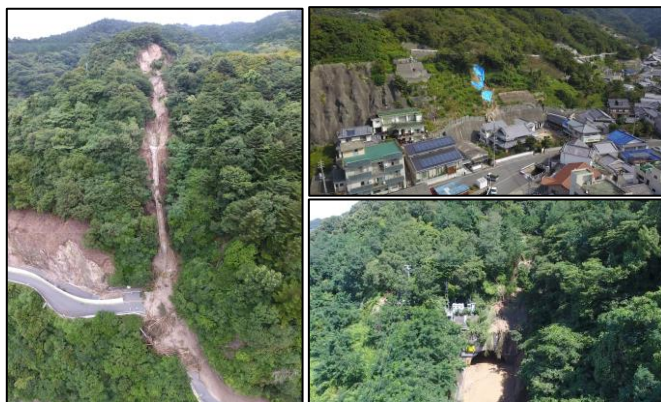
土砂災害の測量
